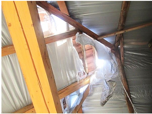
tetőszerkezet, beton cserép fedés
