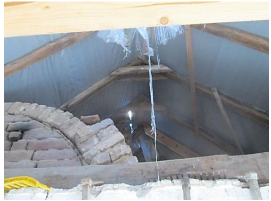
tetőszerkezet, beton cserép fedés
